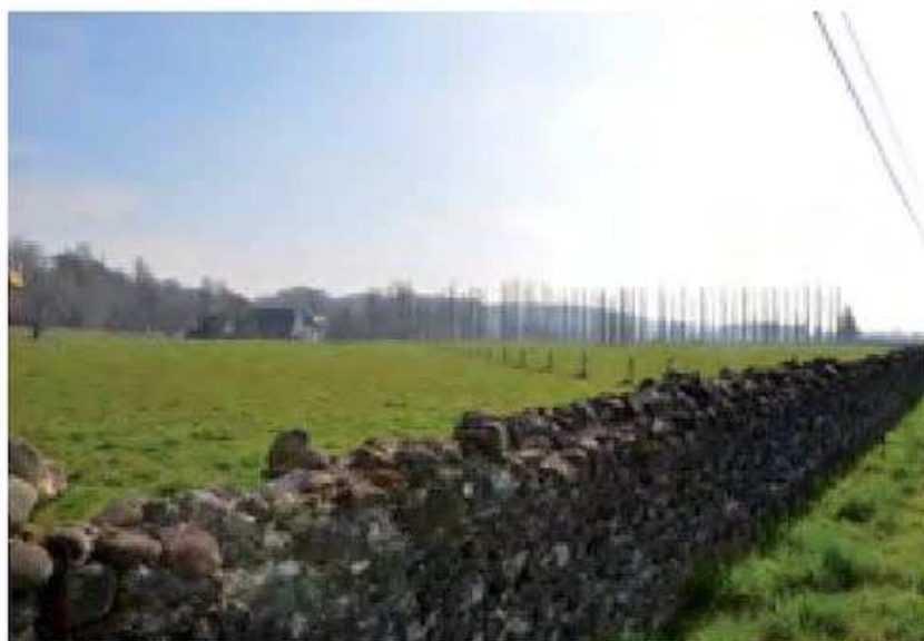
Murs en pierres sèches. Les matériaux ramassés dans le champ ou la prairie constituent le mur. Ci-dessus le couronnement est fait avec de grosses pierres.
