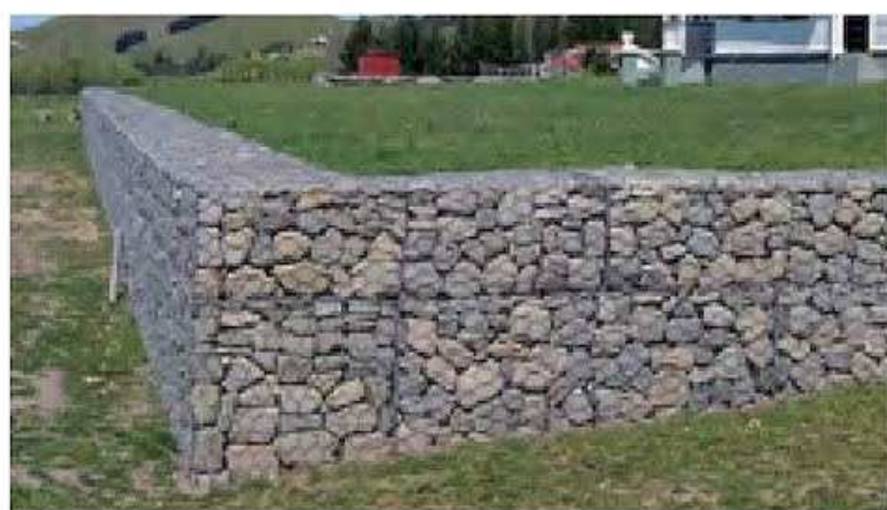
Exemple de murs gabions en soutènement.
