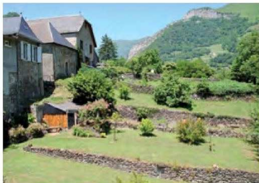
Murs de soutènements entre parcelles
