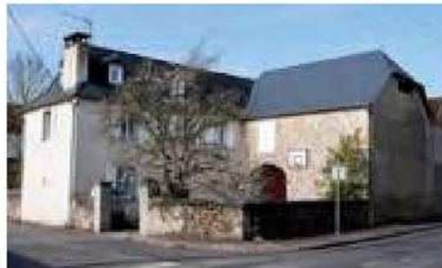
Maison et grange formant une cour. Verdets.
