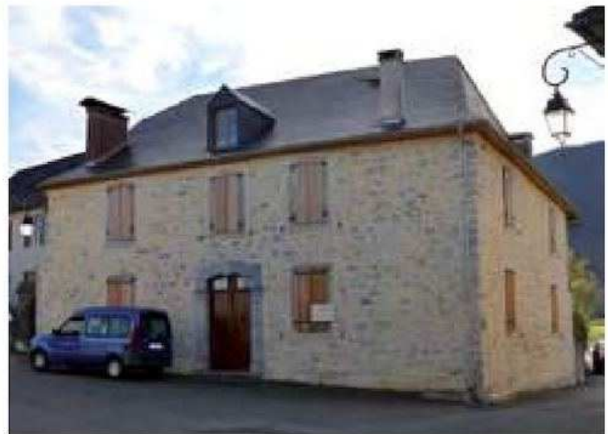
Enduits à pierre rase. Lucarne unique dans la travée centrale. Sainte-Colome.
