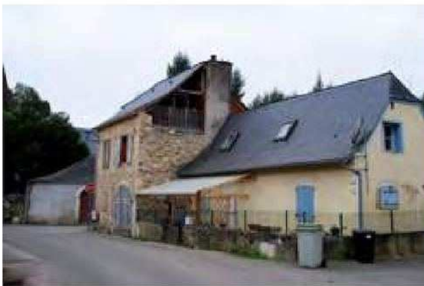
Hiérarchie des bâtis : le logis est enduit, la grange ne l'est pas. Verdets.
