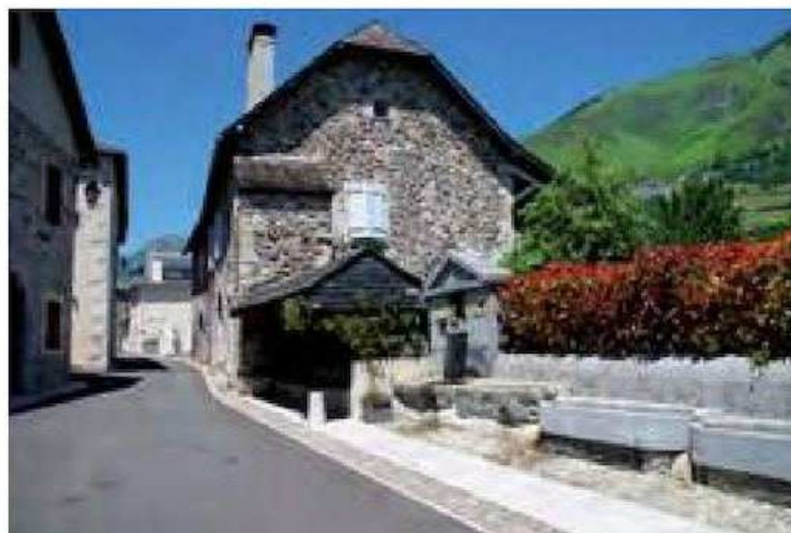
Les ouvrages collectifs liés à l'eau, la rue sinueuse, la limite bâtie. Borce.
