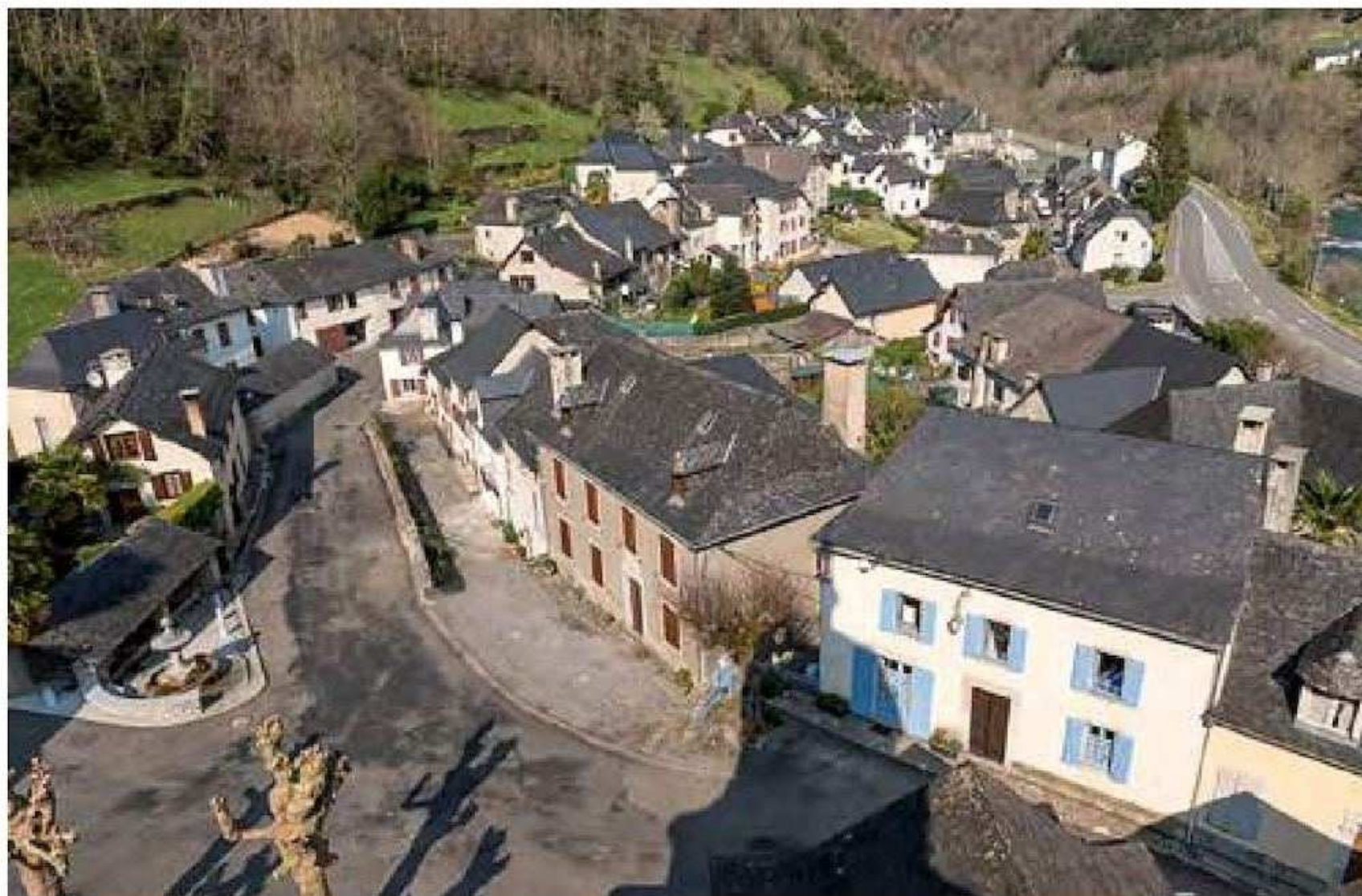
Vue des îlots bâtis. Sarrance.
