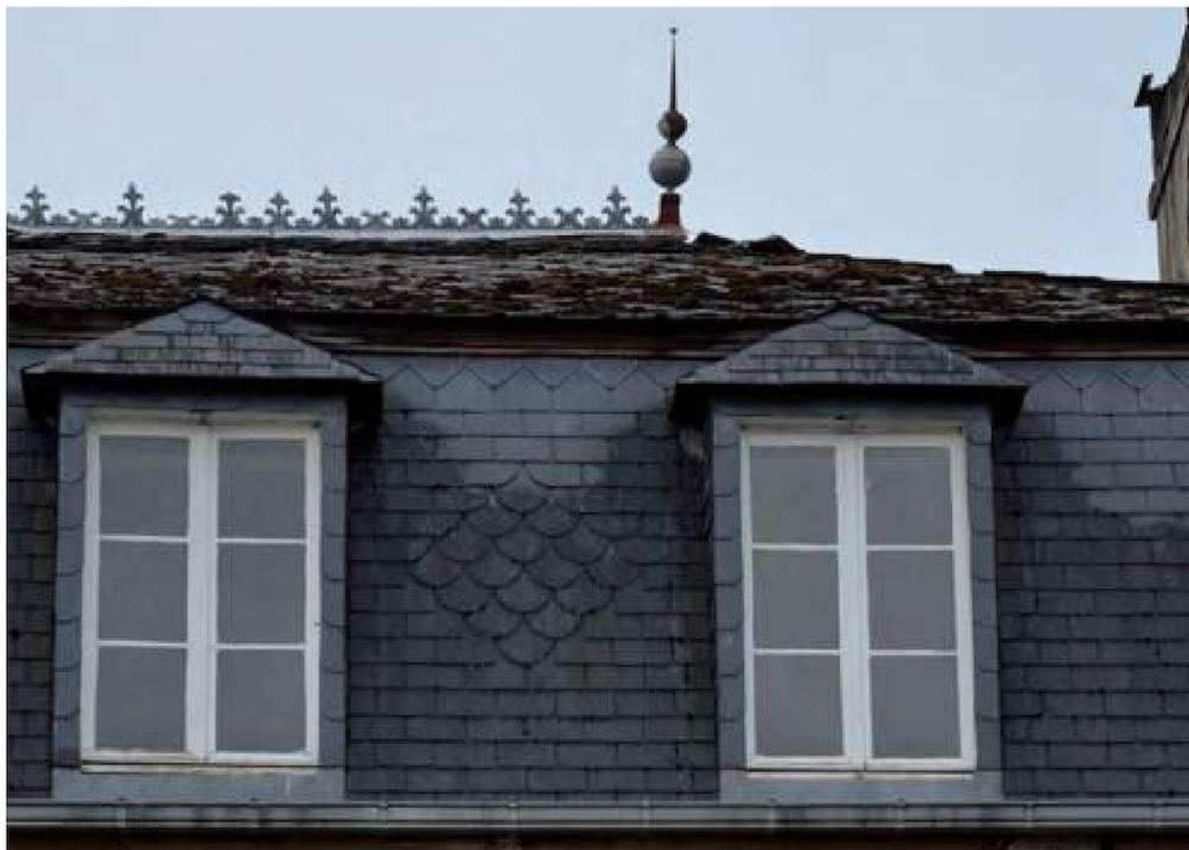
Lucarnes en bâtière sur le brisis d'un toit à la Mansart. Décor d'ardoises taillées en écailles de poissons dans un losange entre les deux lucarnes et épi de faitage et faitière en zinc découpé. Lasseube.
