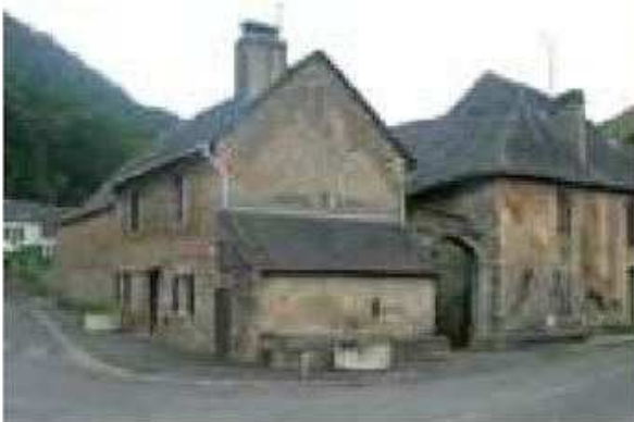
Structure en îlot. Asasp-Arros. Source : © C. BOUCHÉ, CAUE 64.
