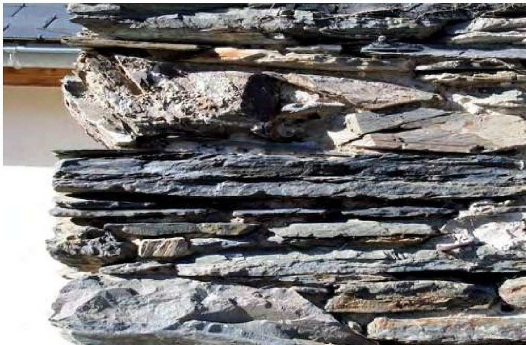
Dalles de schiste appareillées en maçonnerie de pierres sèches dans la vallée d'Ossau. Louvie Soubiron.
