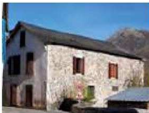
Toiture simple à deux pentes. Bielle.
