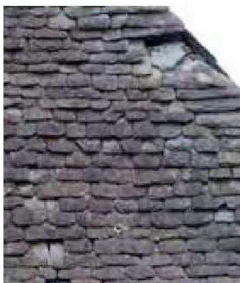
Ardoises épaisses posées au clou. Oloron Sainte-Marie.
