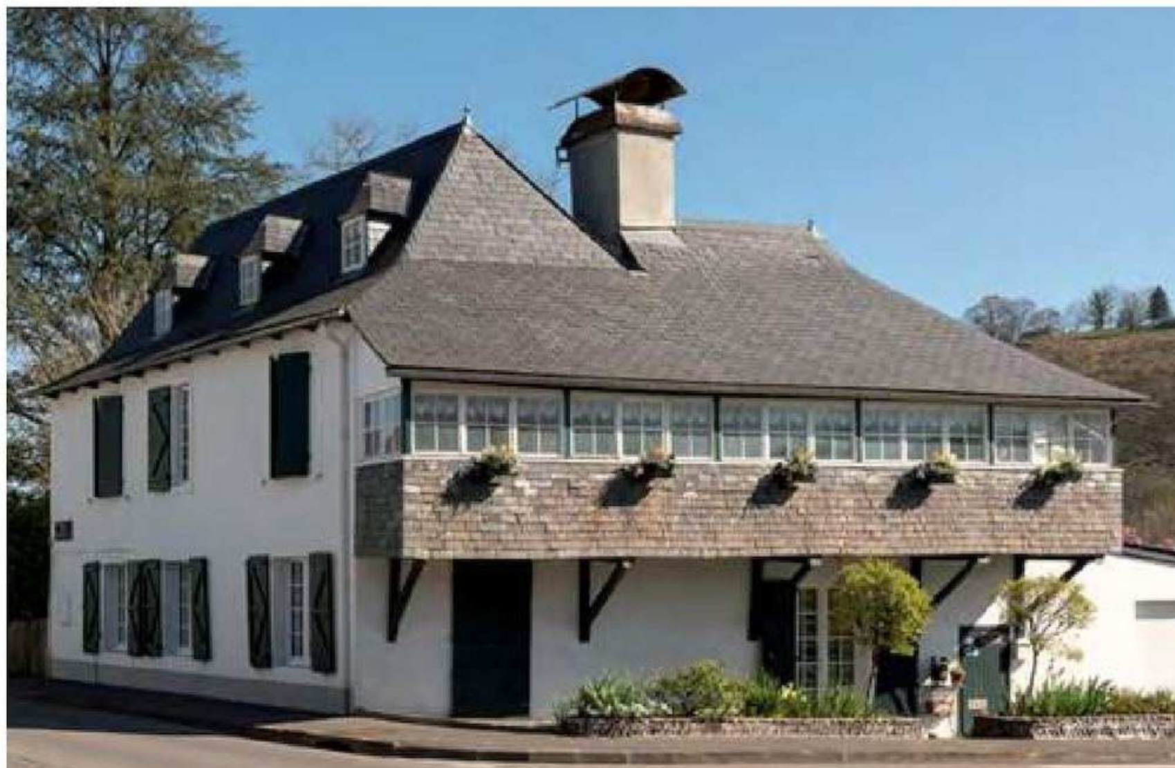
La galerie fermée est une extension de la maison qui présente des propriétés climatiques intéressantes en jouant le rôle d'espace tampon sur la façade. En hiver grâce à l'inertie thermique des ardoises elle emmagasine la chaleur du rayonnement solaire pour la redistribuer à la maison. Féas. Source : Pays d'art et d'histoire © Clément HERBAUX.
