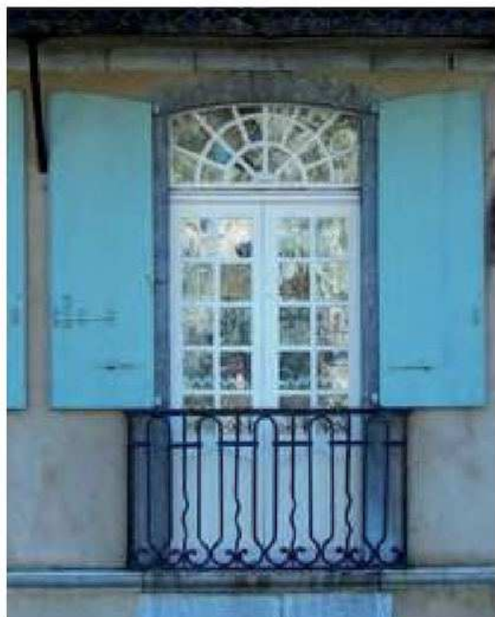
Demi contrevents pleins sur une porte fenêtre et partition à petit carreaux de l'imposte rayonnante et de la fenêtre. Les contrevents épousent la forme incurvée de de la partie supérieure de l'encadrement. XVII e - XIX e siècle.
