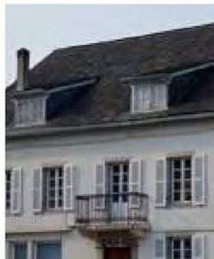
Lucarnes rampantes. Issor.
