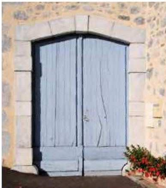
Porte à planches et contre-planches. Bescat.
