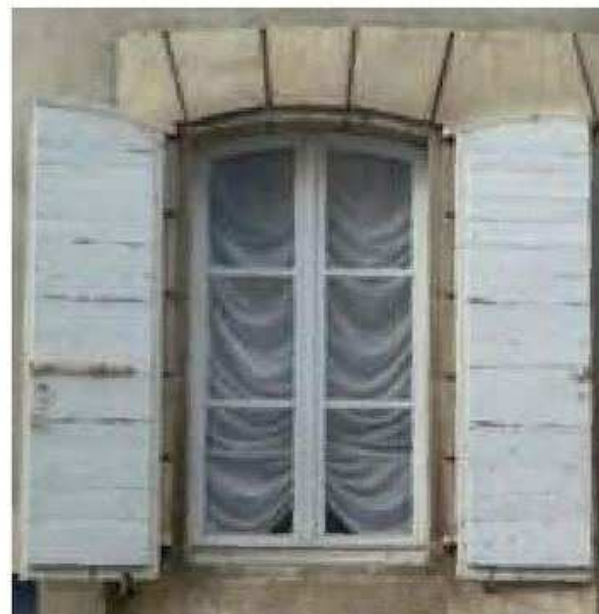
Fenêtre XVIII e siècle, partition à grands carreaux, volets en planches et contre-planche qui s'inscrivent dans la feuillure de l'encadrement.
